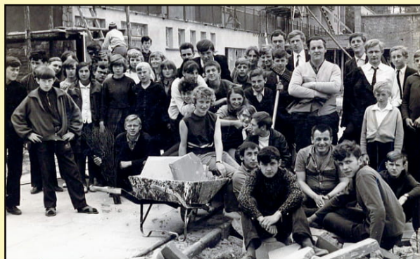
1968 r. Z zawodnikami LZS „Orzeł” z Dłużyny w przerwie pracy społecznej przy budowie gmachu późniejszego hotelu „Syrena” w Boszkowie-Letnisku
